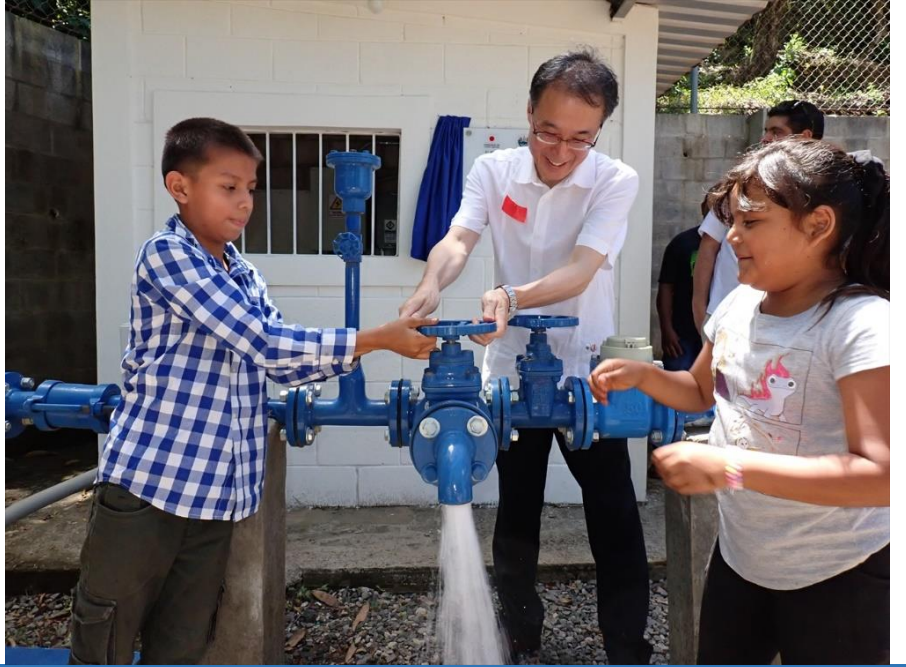
❖ Apertura de la válvula del Sistema de Agua Potable en caserío El Mirador, cantón Portezuelo, distrito de Santa Ana.
