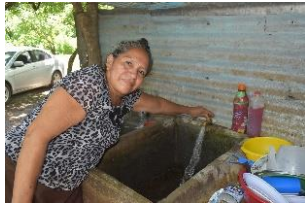
写真1 (上水道整備) : 日本の協力により、上水道 が設備され喜ぶ裨益者
