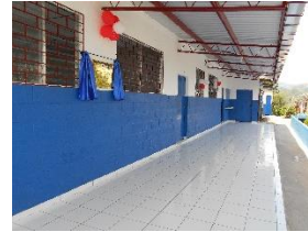
写真3 (学校) : 日本の協力により新設・改 修された学校
