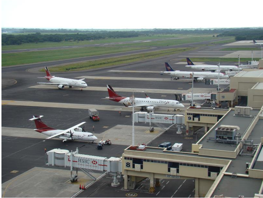
1980年に完成し、今日に至るまで中米最大級のハブ空港として、 中米地域の発展に貢献しているエルサルバドル国際空港
